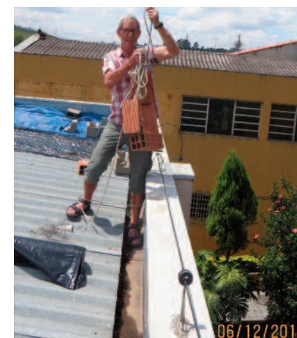
Jo van Mil bij een provisorische reparatie van het dak
